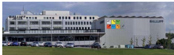
Die Balluff Firmenzentrale in Neuhausen auf den Fildern.
