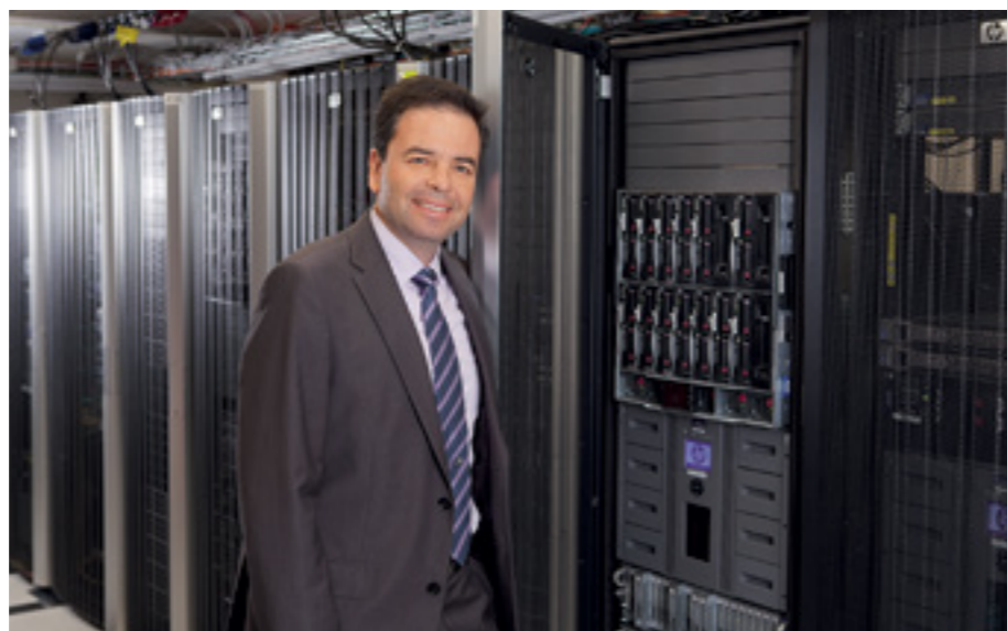
Wo sonst! Für das Fotoshooting bat AEB ins Rechenzentrum des Unternehmens.
